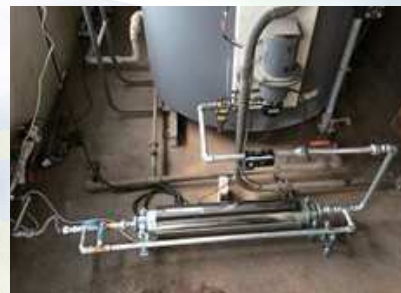
バイオストレーナー設置 流量計測状況写真
